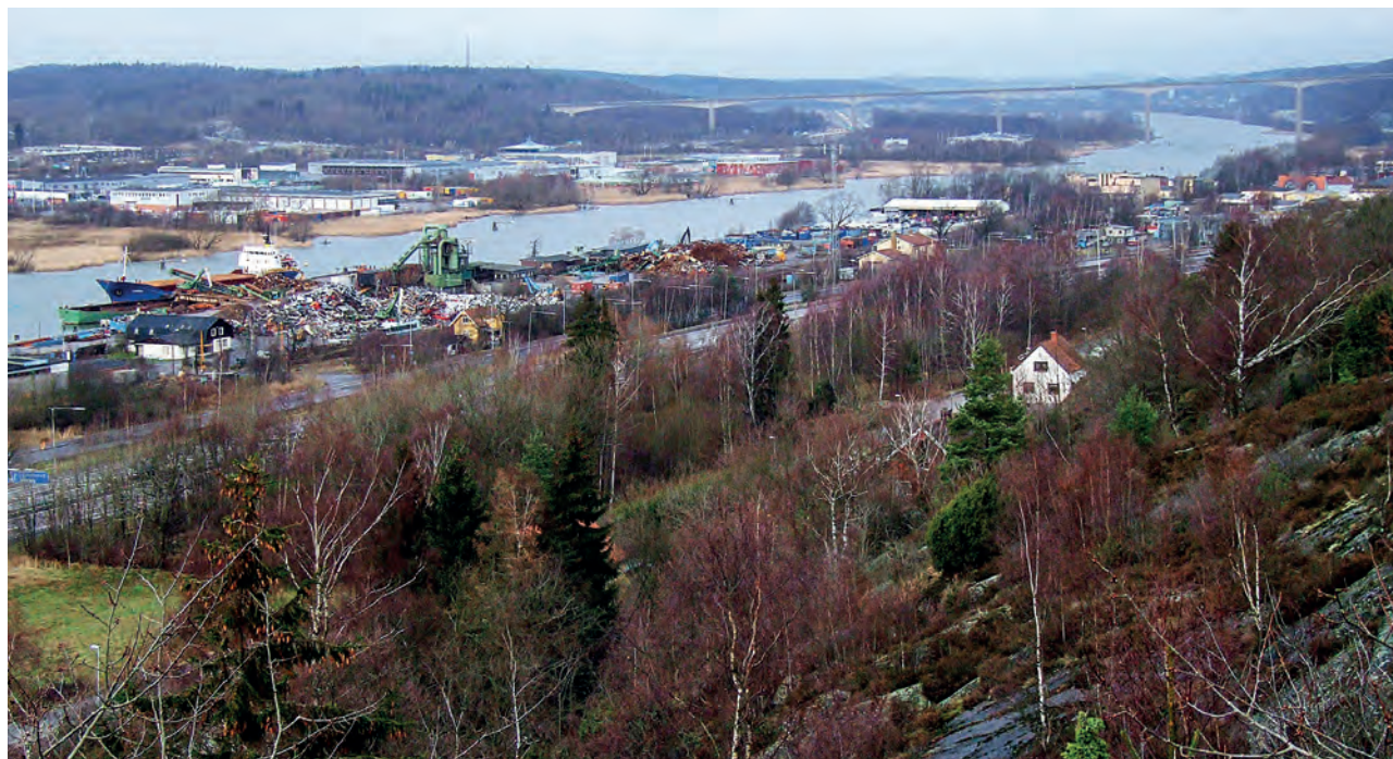
Göta Älvdalen vid Agnesberg och Agnesbergsbron har många historiska skikt sida vid sida. Här ligger en äldre randbebyggelse vid älven som har förlorat kontakten med densamma. E-45 breder ut sina vägbanor där emellan och intill ligger rester av det sena 1800-talets och det tidiga 1900-talets industrietablettingar i området.
