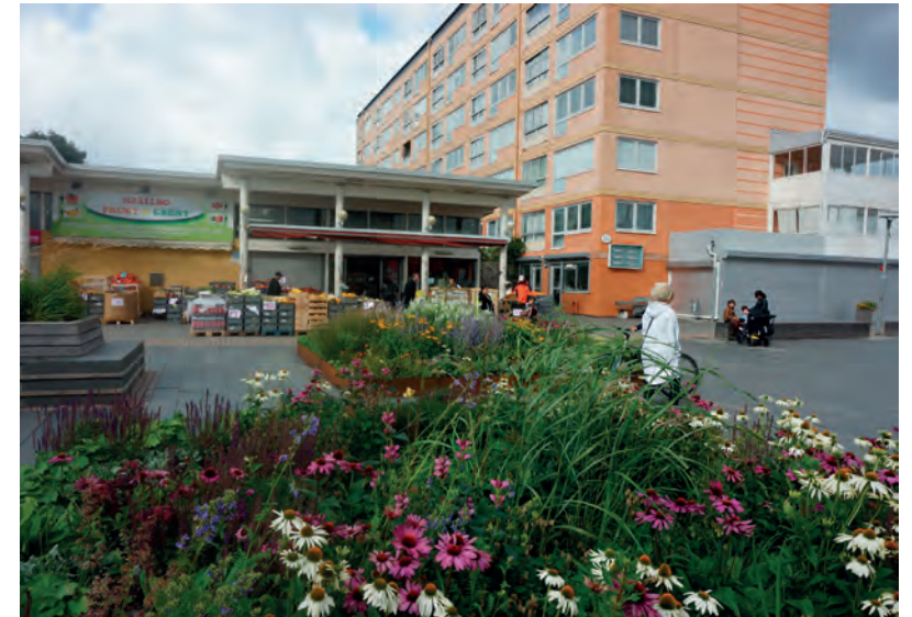
Hjällbo torg – mitt i en stadsdel som rustats upp på olika sätt
