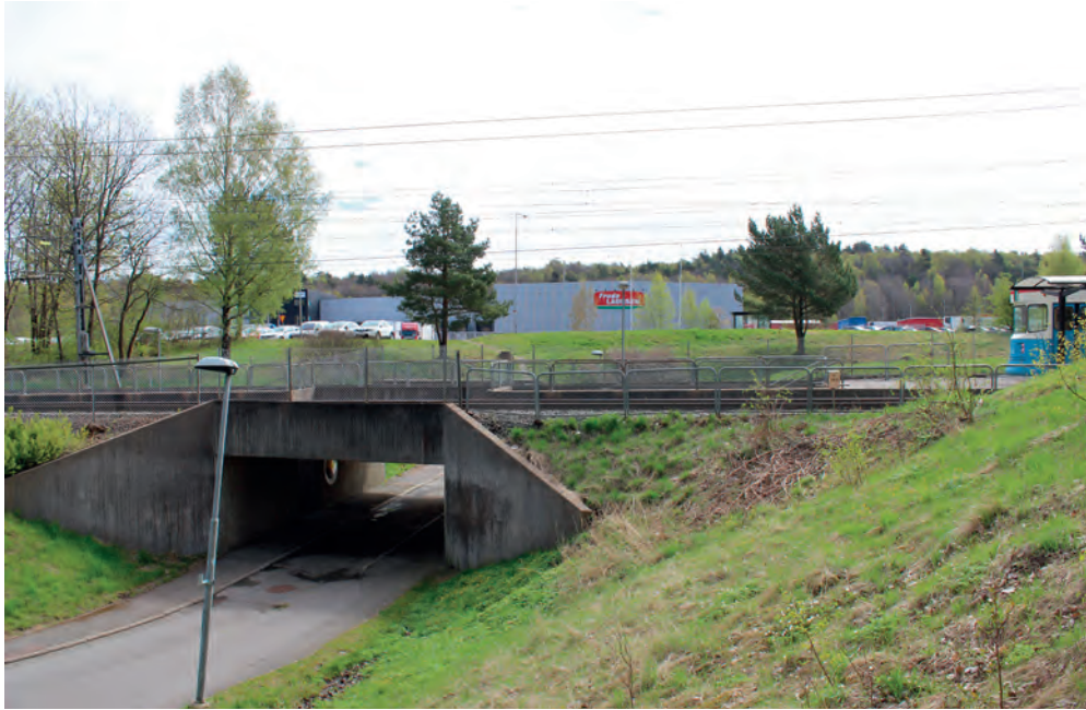
2.1 Själva spårväghållplatsen Storås ligger i ett industri- och hantverksområde med separerade bil-, cykel- och gångvägar på ett modernistiskt sätt. Den är placerad utmed spårvagnsspåren med separerade nivåer för olika trafikslag.
