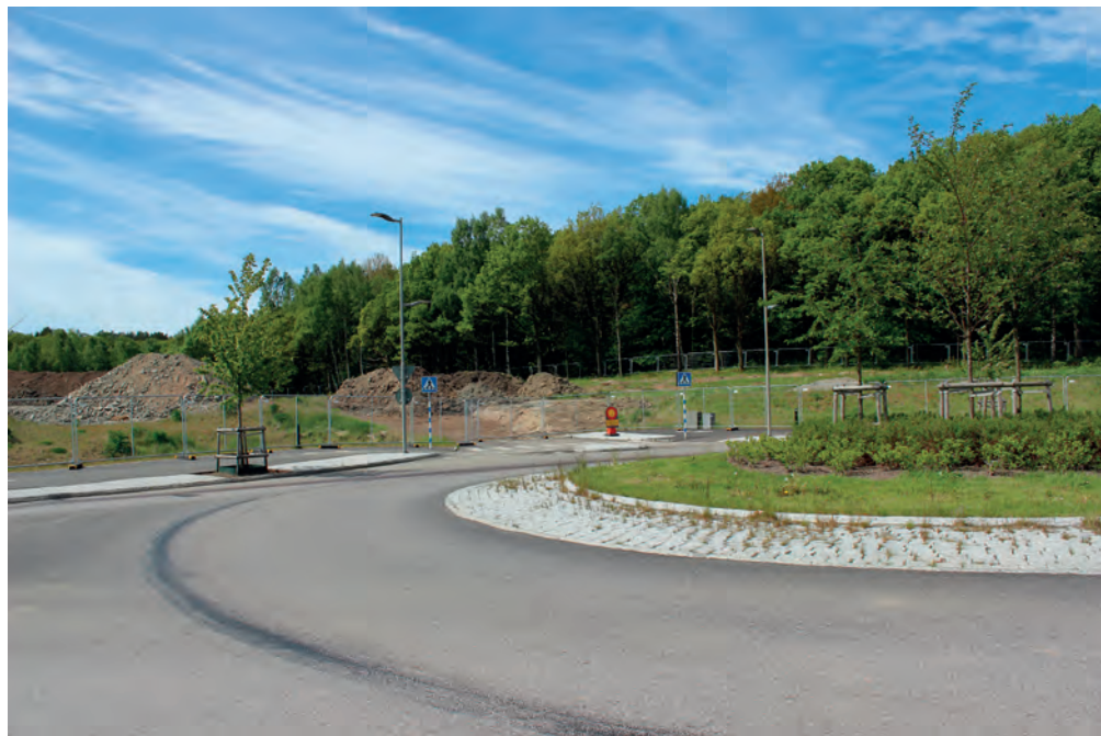
4.1 Väster om det nya Närsjukhuset i Angered ligger ett område med lövskog och äldre odlingslandskap. Här byggs det just nu och kopplingarna till Angered centrum kommer att vara viktiga då det gäller tillgänglighet.
