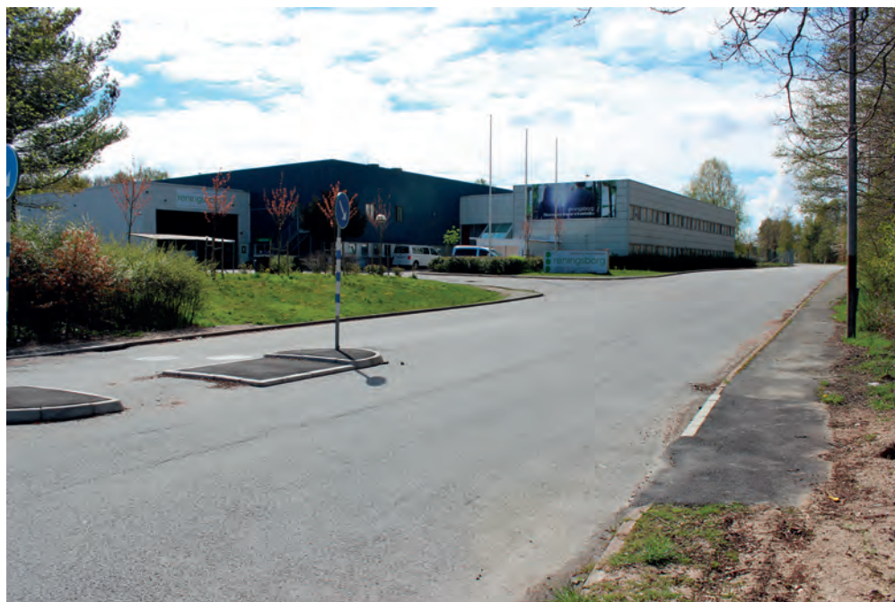
6.1 Råvebergsvägen är kantad av industri- och hantverkslokaler som Reningsborg, brandstation och Angeredscentralen. Vägarna innanför Råvebergsvägen är breda och det är biltrafiken som prioriteras. Små och märkliga trottoarer dyker emellanåt upp.
