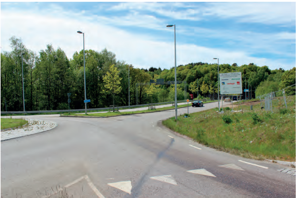
4.2 Vägområde med cirkulationsplats mellan Övre Storåsvägen och Titteridammsvägen saknar helt anknytande bebyggelse idag. Den kommande bebyggelsen kan komma att ändra på upplevelsen av trafikmot för bilar.
